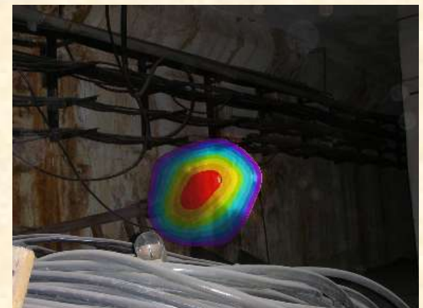
Места протечек из бассейна выдержки на БАЭС
